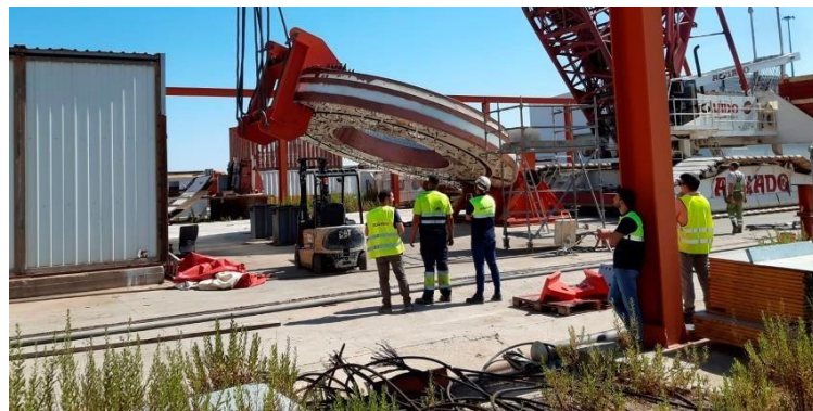
Figura 2. Montaje de TBM
