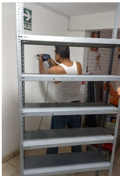
Figura 32. Se observa la instalación de anaqueles.
