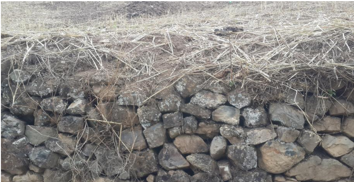
Figura Nº5.-imagen de muro de piedras o barreras muertas
