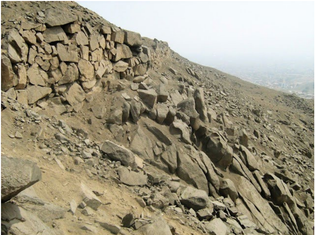
Figura 15 Perfil de la "Tercera muralla" sobre la ladera rocosa del cerro
