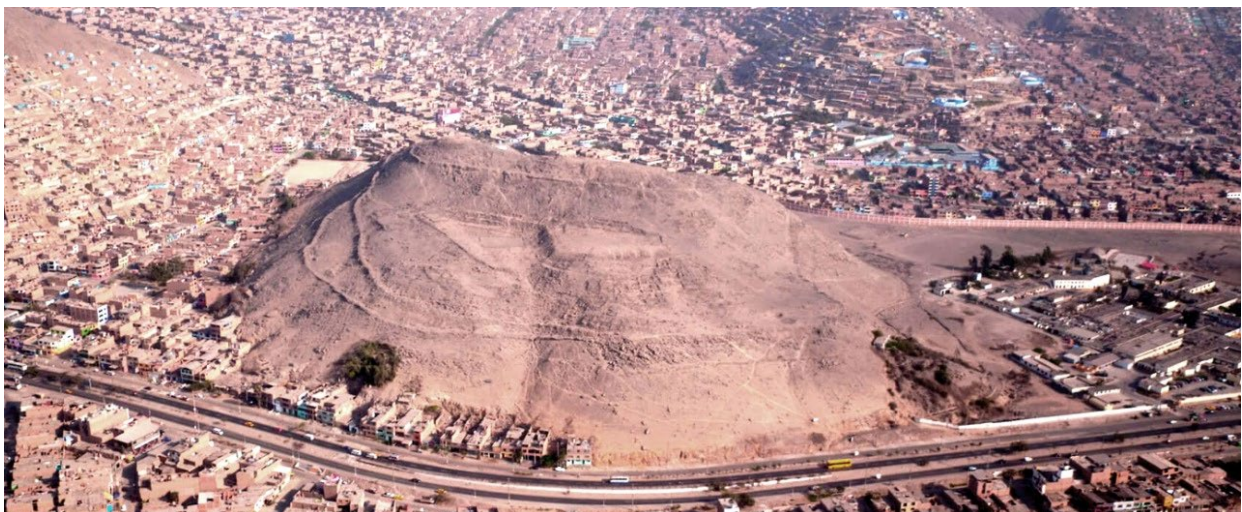
Figura 14 Fotografía actual de la Fortaleza de Collique
