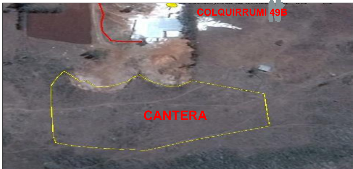
Figura 36. Cantera de la concesión Colquirrumi 49B.
