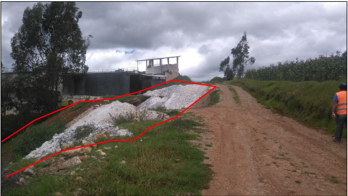
Figura 44. Pérdida de cobertura por desmonteras.
