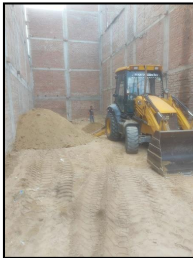
Figura 1. Excavación masiva del terreno con el cucharón excavador de la retroexcavadora profundidad 15cm
