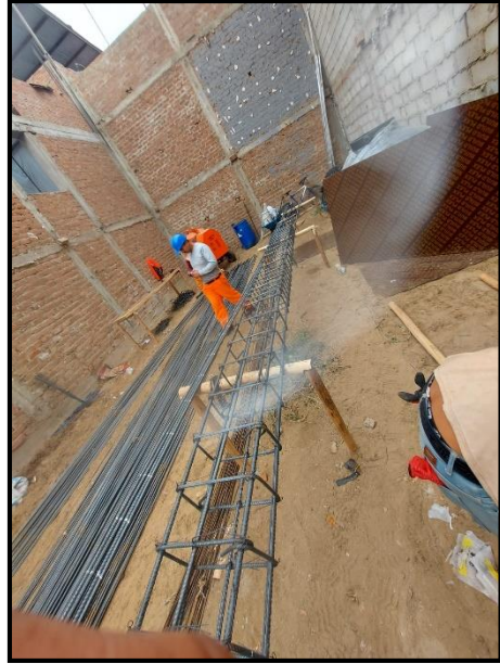
Figura 9. Excavación de la Viga de Cimentación
