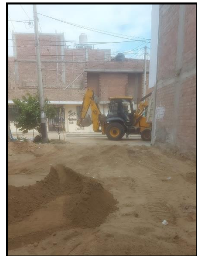
Figura 2. Recolección de material excavado con el cucharón cargador de la retroexcavadora
