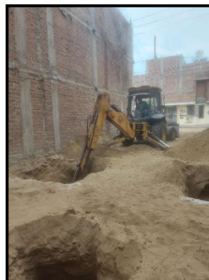
Figura 1. Excavación masiva del terreno con el cucharón excavador de la retroexcavadora profundidad 15cm
