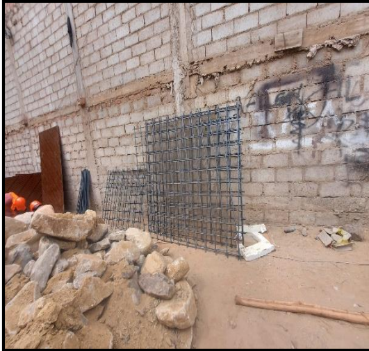
Figura 8. Armado de columnas
