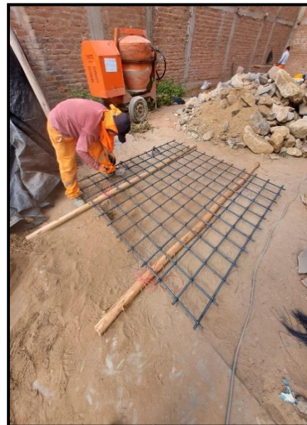
Figura 7. Parrillas habilitadas y armadas
