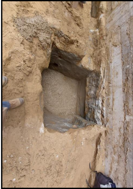
Figura 4. Vaciado de solado
