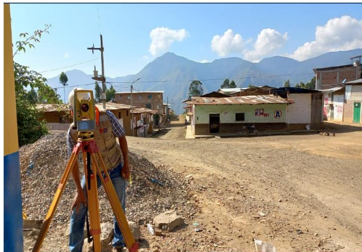
IMAGEN N° 02. INSTALACIÓN DE ESTACIÓN TOTAL PARA INICIOS DE TRABAJO.
