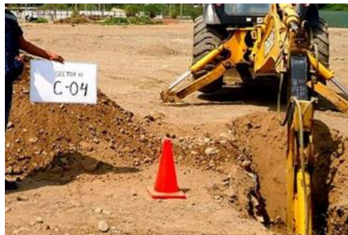
Figura 9. Realización de calicatas. Fuente: Elaboración propia.
