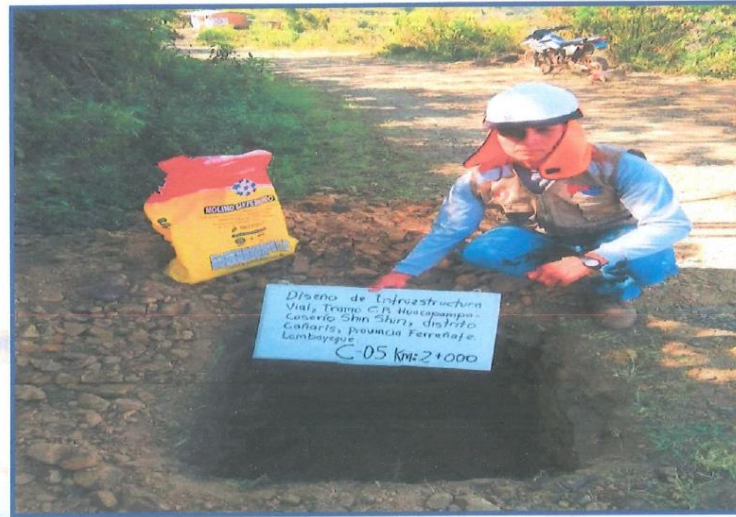
Foto N° 5. Detalle del perfil del suelo de Calicata C-5, Prog. 2+005.
