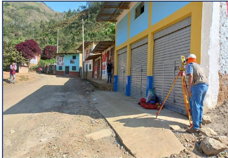
IMAGEN N° 01. RECONOCIMIENTO DE TERRENO E INSTALACION DE EQUIPO TOPOGRAFICO (ESTACION TOTAL) – C.P. HUACAPAMPA.
