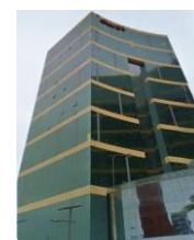
Torre Parque Mar (2000)
