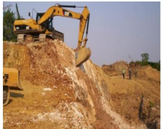
COEFICIENTES DE EXPANSIÓN DE SUELOS EXCAVADOS
