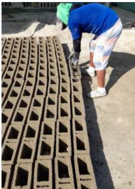
Puesta en planta para secado y curado constante Fuente: Elaboración propia
