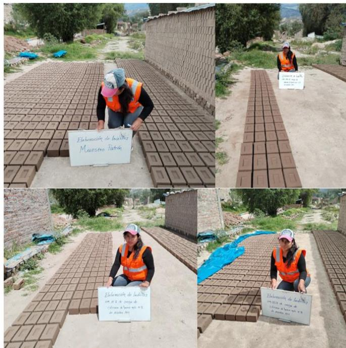
*Figura 19.* Moldeado de los ladrillos
