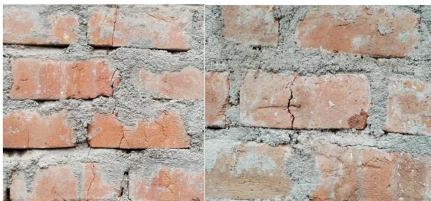
*Figura 1. Falla en muros de ladrillo artesanal*
