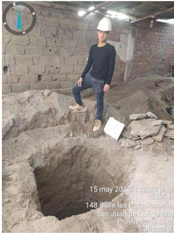
**Figura 30.** Calicata 01: 1.50x1.50 metros con profundidad 3 metros
