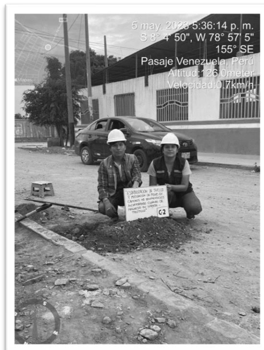
Excavación para obtener muestras en la calicata 2
