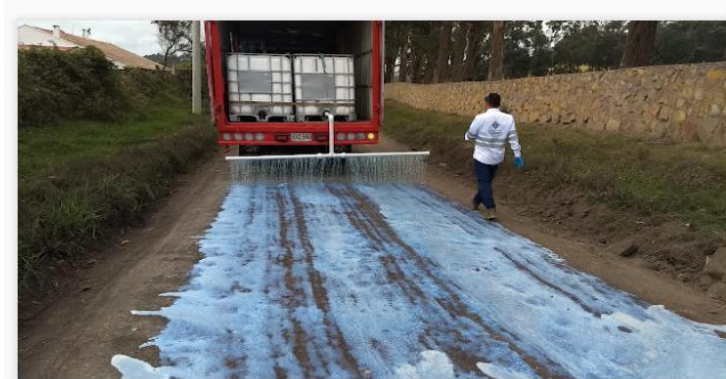
Figura 1. Aplicación de estabilizador de suelos.
