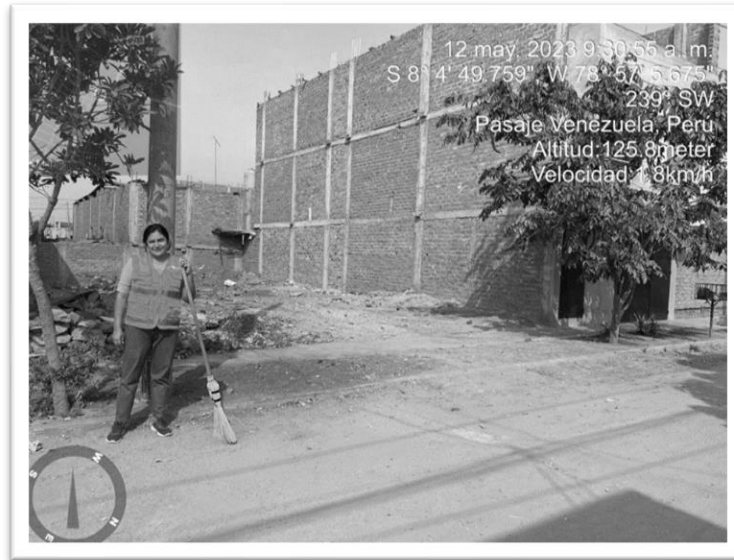
Iniciando con la limpieza del área a trabajar
