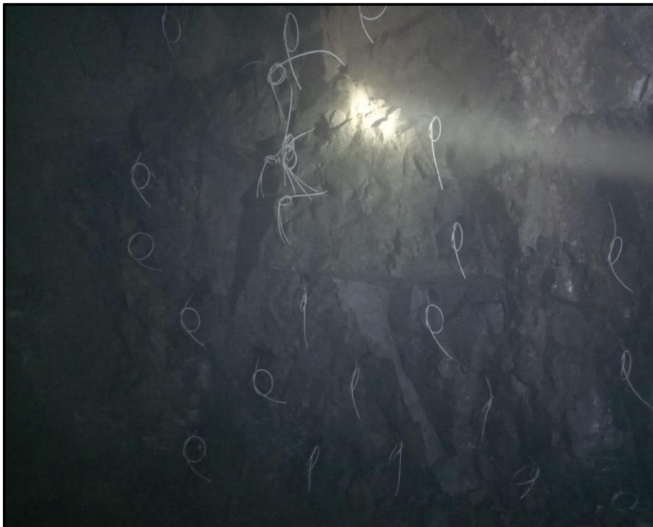
Figura 17: Malla de perforación realizada en la galería E01.
