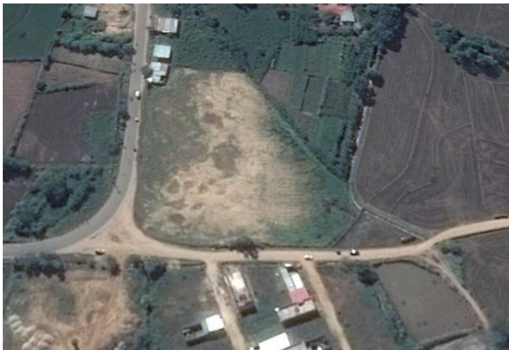
Figura 12. Imagen satelital del terreno 01 (elaboración propia).
