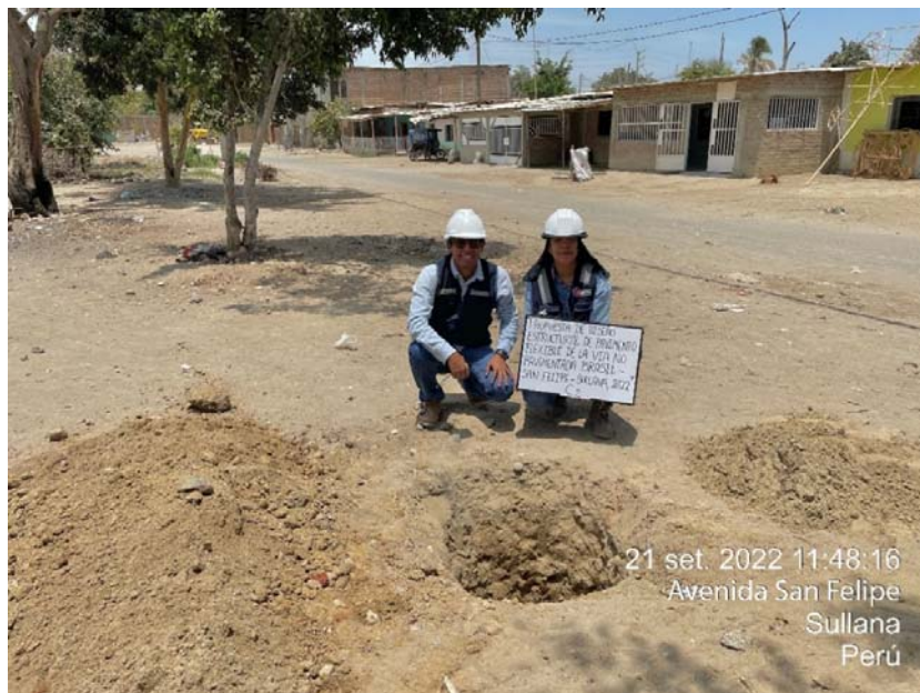
En la fotografía se observa la calicata C-2
