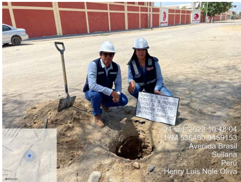
En la fotografía se observa la calicata C-1
