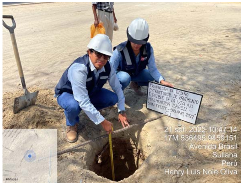
En la fotografía se observa la medida de profundidad de la calicata C-1
