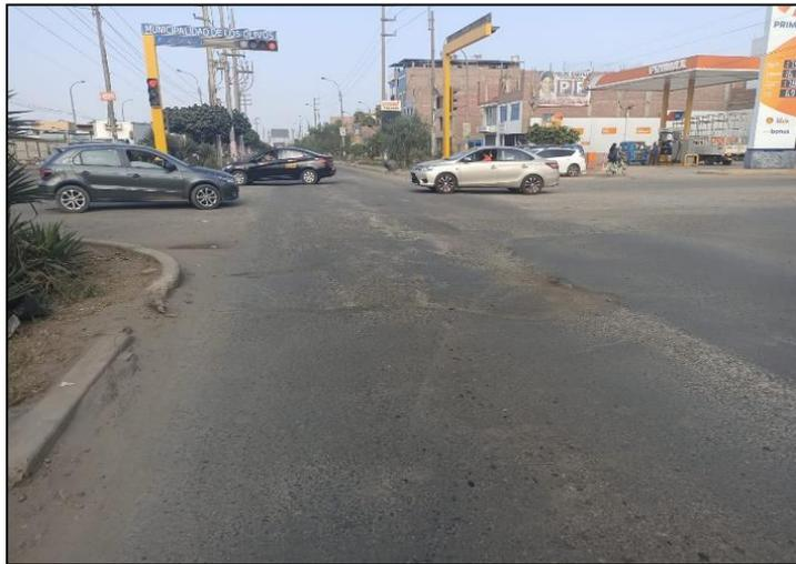
Figura 17: pavimento flexible - Av. 2 de octubre con hundimientos
