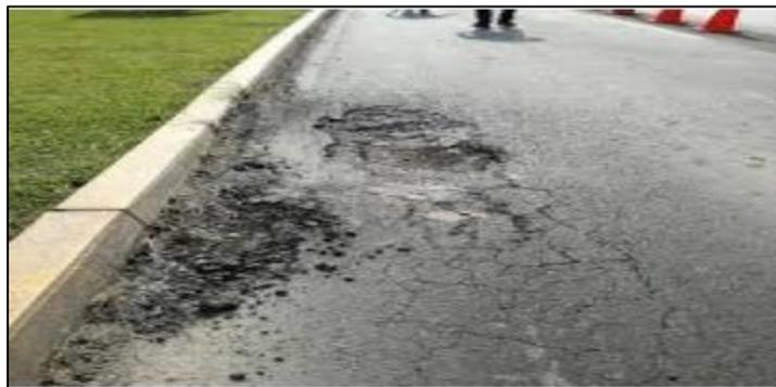
*Figura 3: Hundimiento y abultamiento*
