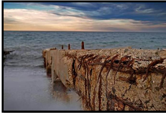
Figura 3. Penetración de sulfatos
