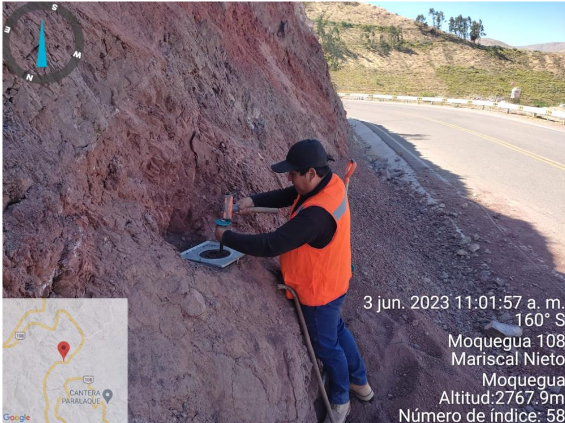
Ensayo de densidad en parte media del talud.
