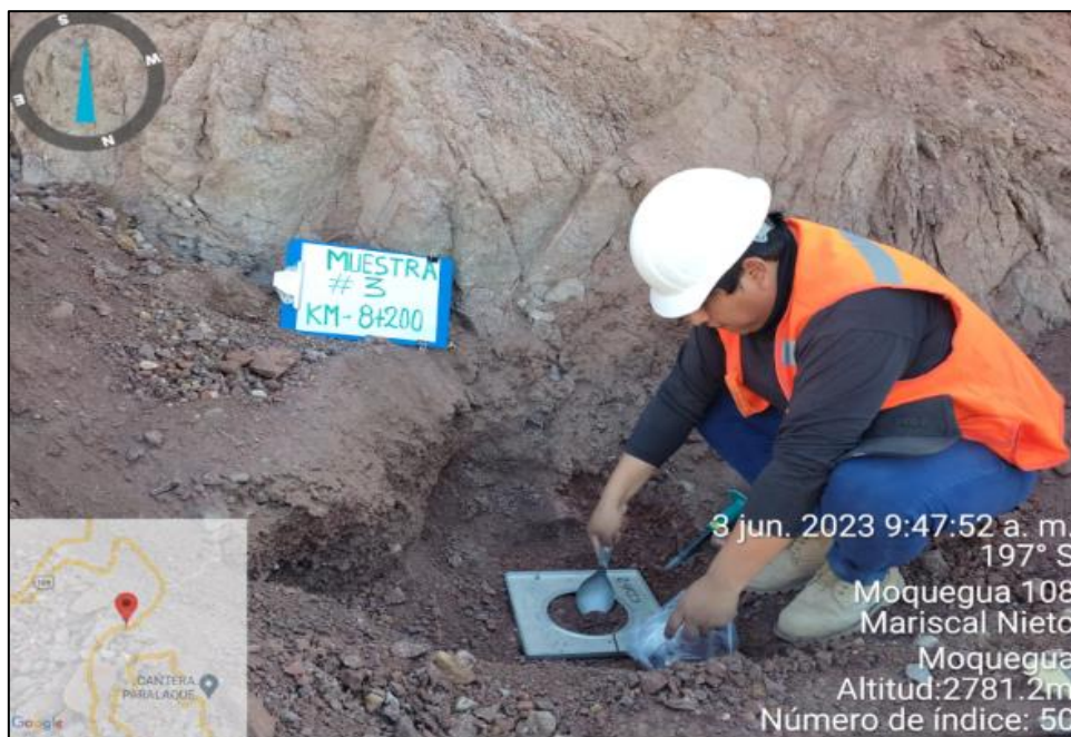
Figura 16. Talud tramo 03 km 8+200, Ensayo de Densidad
