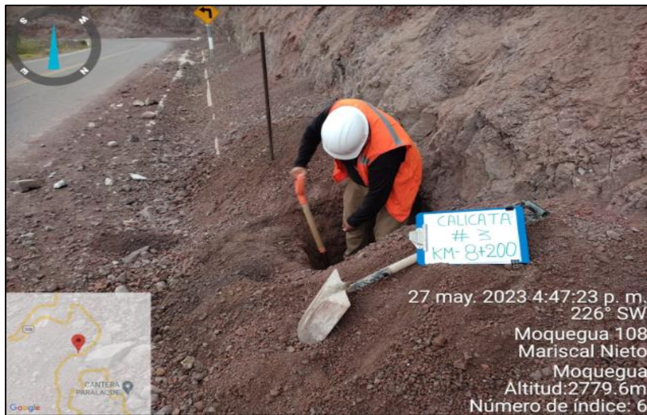
Figura 13. Talud tramo 03 km 8+200 Excavación de Calicata.
