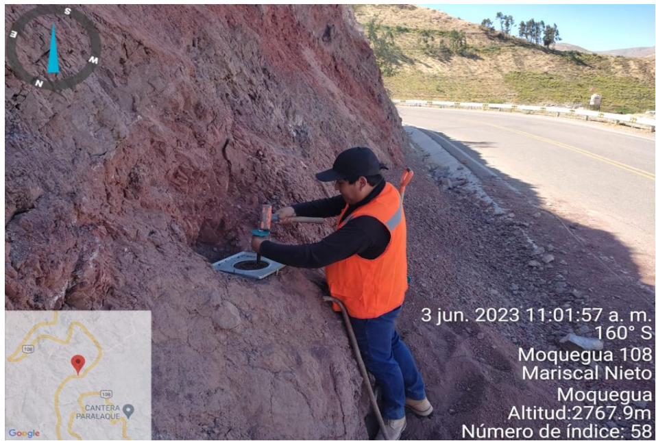
Figura 15. Talud tramo 03 km 8+200, Ensayo de Densidad
