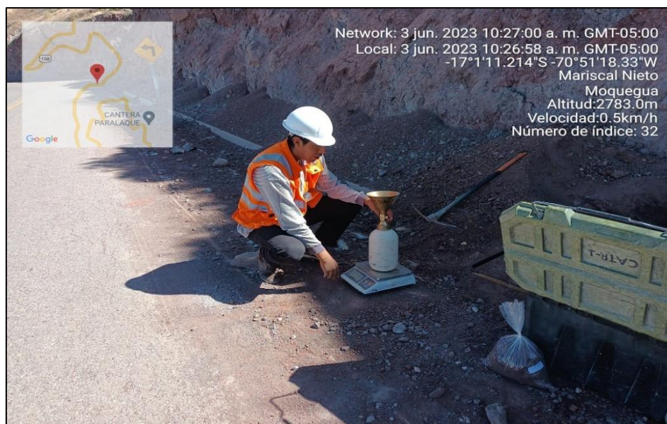
Figura 17. Talud tramo 03 km 8+200, Ensayo de Densidad
