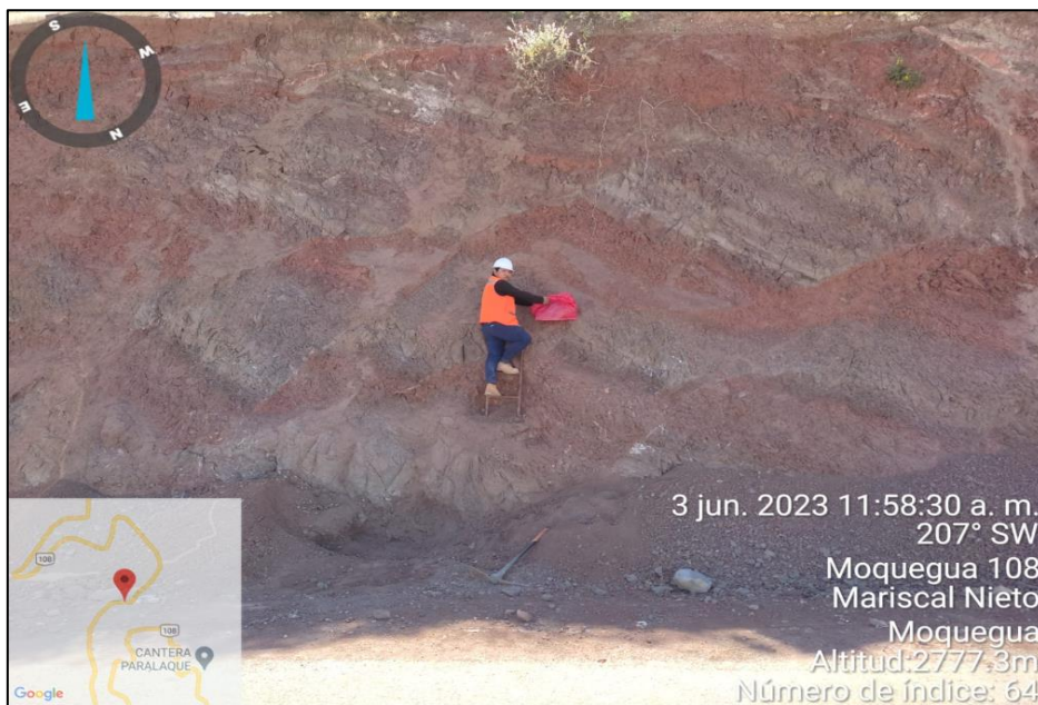
Figura 14. Talud tramo 03 km 8+200 Extracción de muestra - Trinchera.
