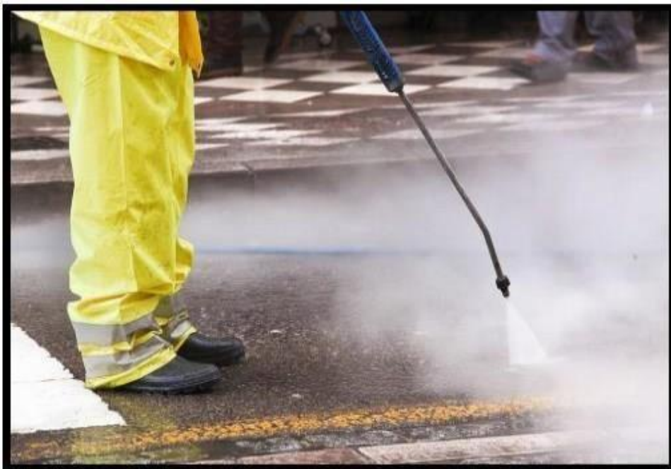
Figura 28 Saturado de la capa asfáltica
