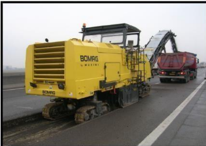
Figura 26 Fresado de la capa asfáltica
