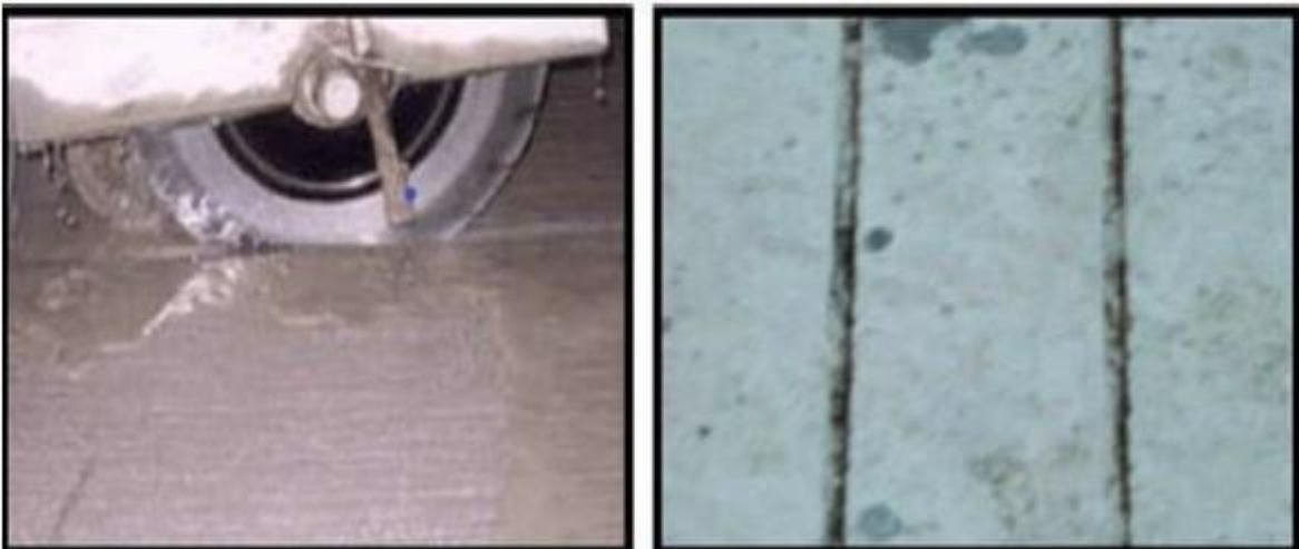
Figura 32 Aserrado para juntas de dilatación
