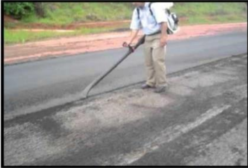
Figura 27 Limpieza del pavimento
