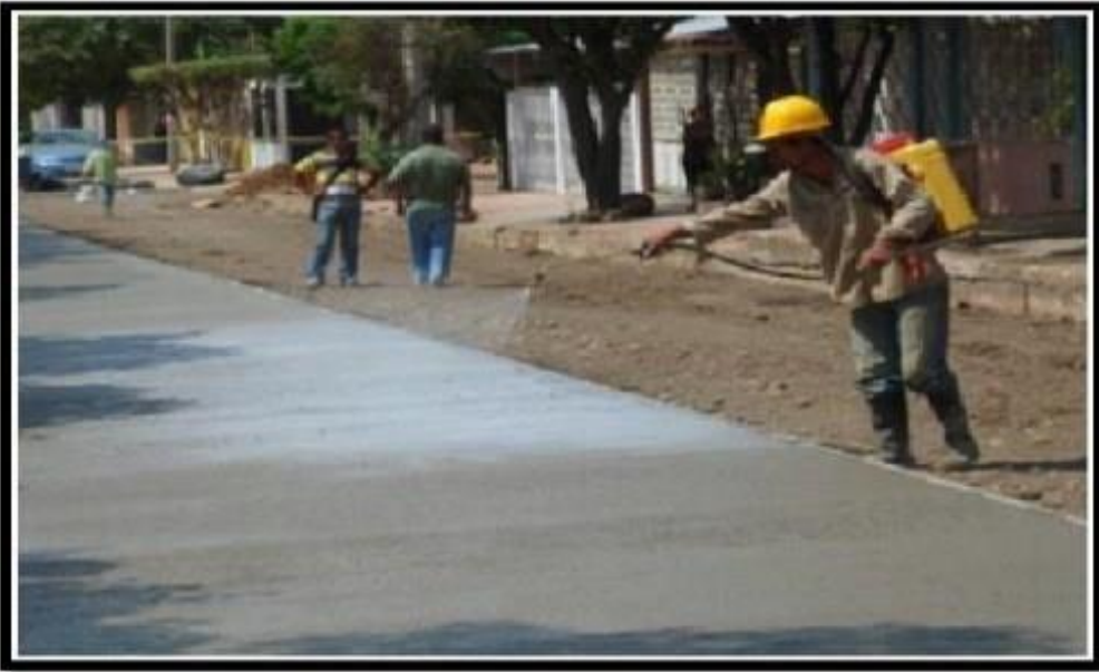
Figura 31 Curado mediante químicos para lograr un óptimo desempeño
