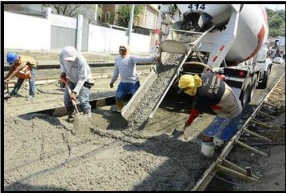
Figura 29 Vaciado del concreto
