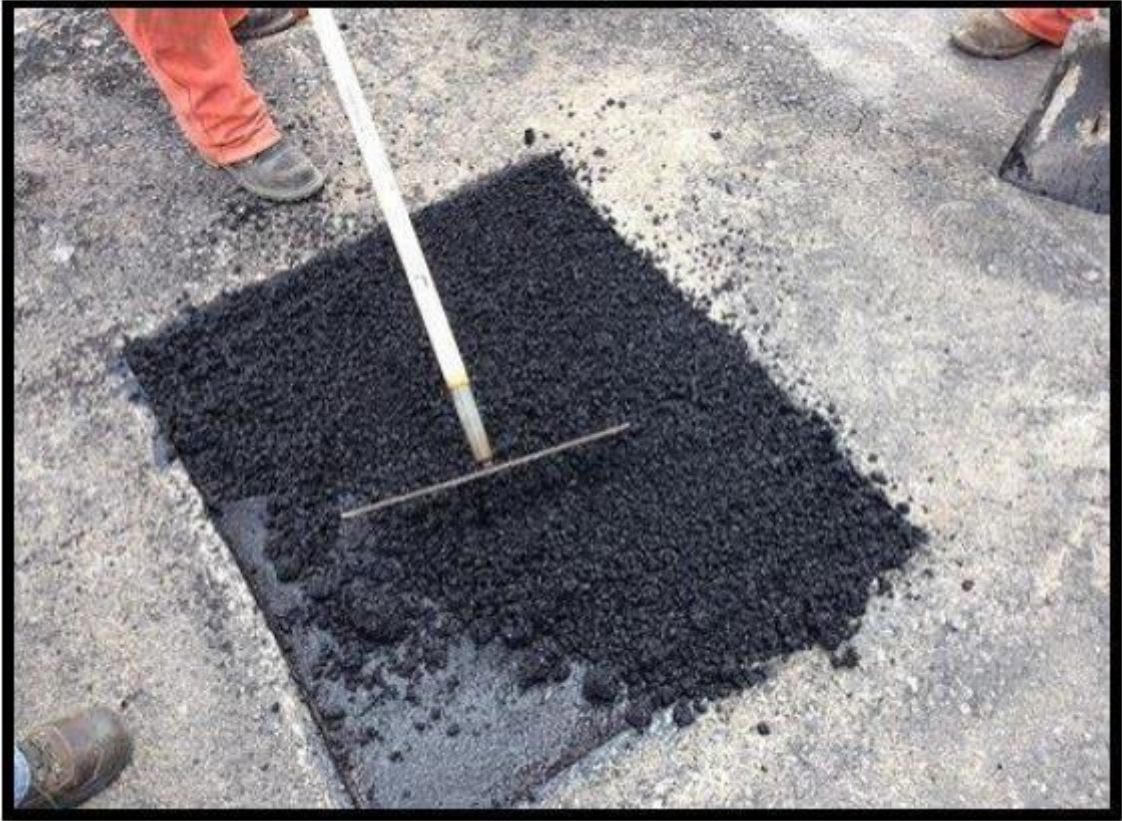
Figura 25 Relleno del hueco presente en la capa asfáltica
