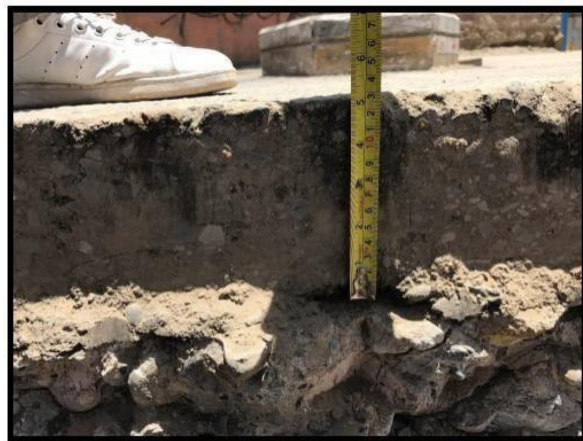
Vista del Espesor del Pavimento existente
