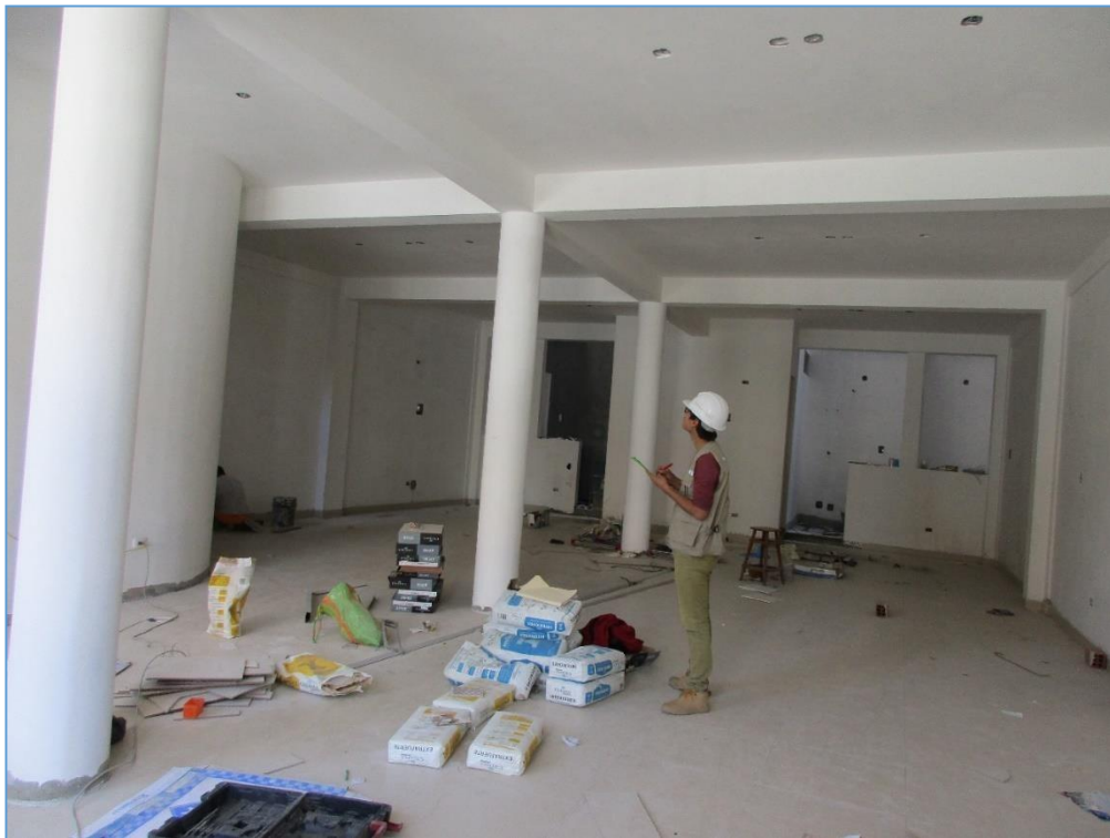
Fotografía 2. Inspección del primer nivel del edificio.
