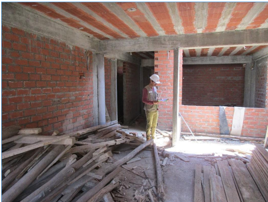
Fotografía 4. Inspección a niveles superiores.
