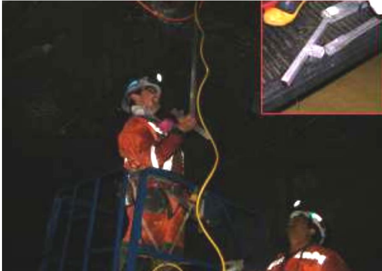
Figura 4. Alineación del sensor según el Norte geográfico. Extraído de “Análisis de sismicidad inducida en mina subterránea Río Blanco Sector Norte III Panel áreas 15, 16 y 17 Nivel 16 hundimiento Codelco división Andina” y elaborado por Romero (2012) ( https://www.dgeo.udec.cl/wp-content/uploads/2013/07/romero_diego_tesis.pdf )
