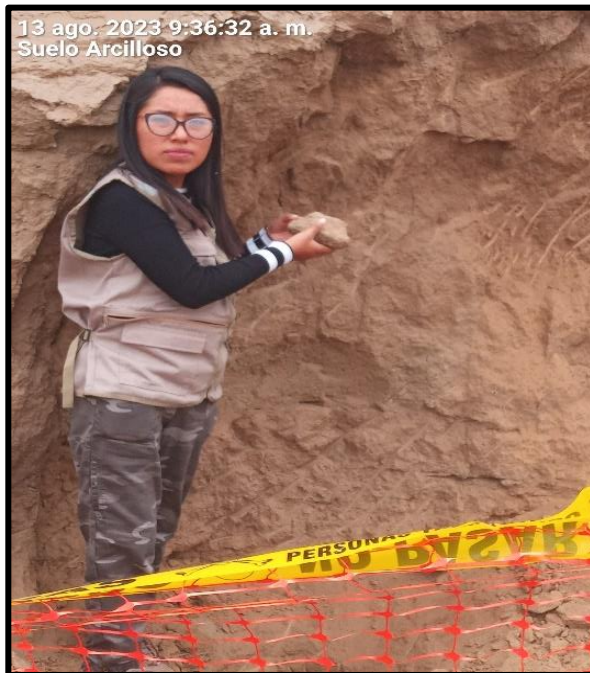
Figura 21 Excavación de Calicata
