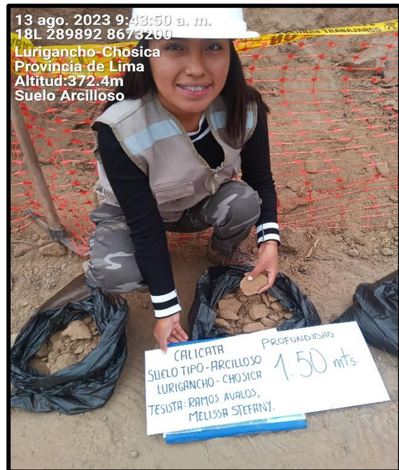
Figura 22: Excavación de Calicata
