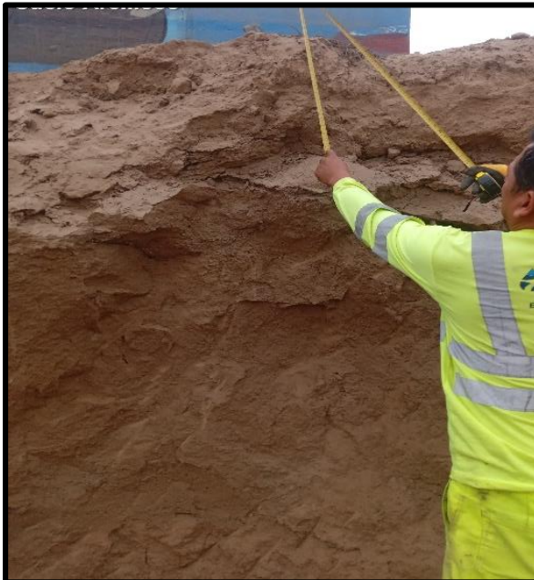
Figura 19: Excavación de Calicata
