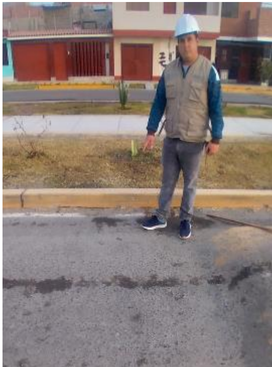
Figura 9: Pulimiento de agregado– Calle 35
