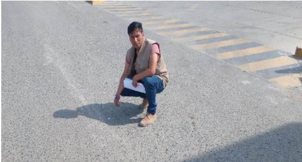
Figura 6: Identificación de las patologías – Av. Aviación
