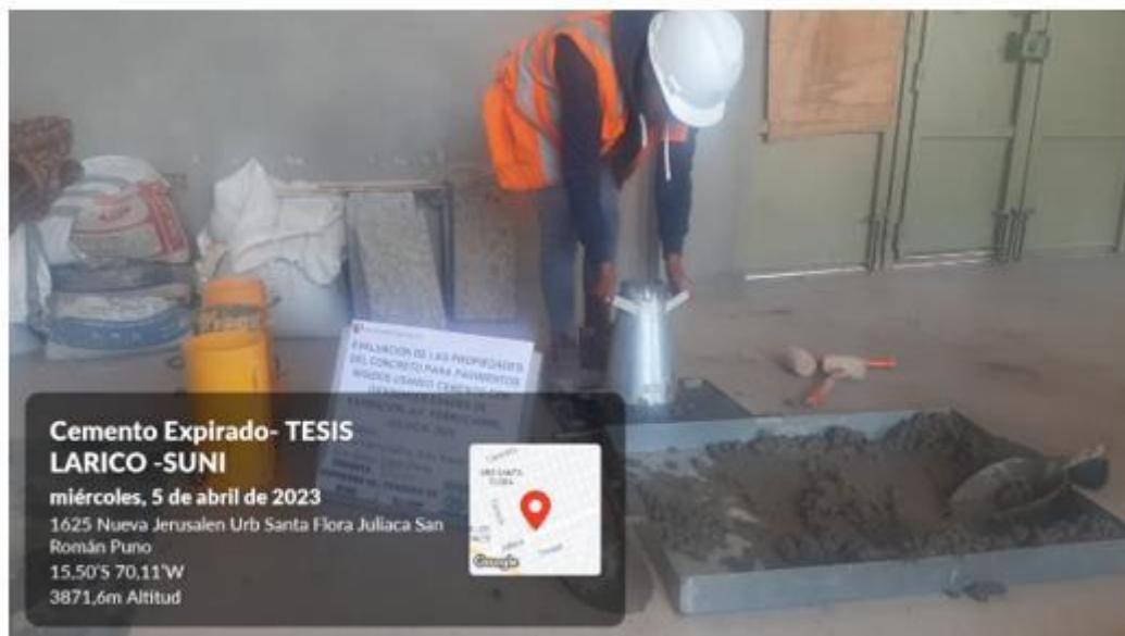
Fotografía 14. Ensayo de Cono de Abrams.
