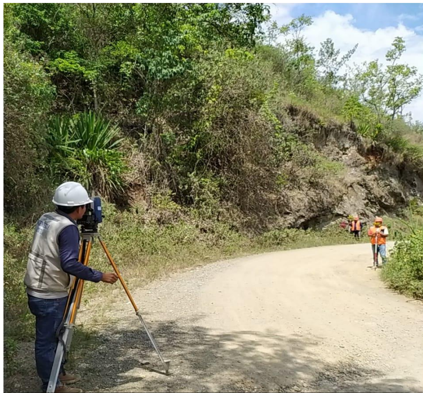
Figura 5: Trabajo levantamiento topográfico
