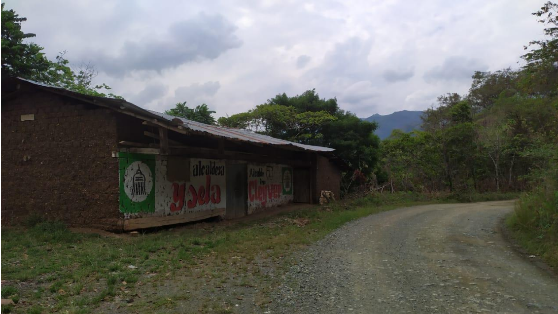
Figura: Evidencia del polvo que afecta a las viviendas aledañas
