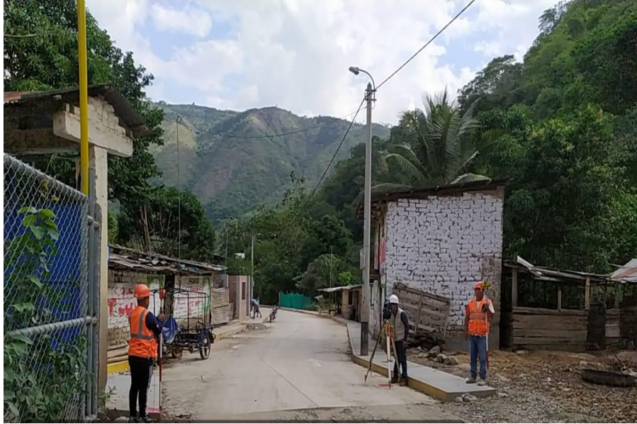
Figura 2: Inicio del levantamiento topográfico
