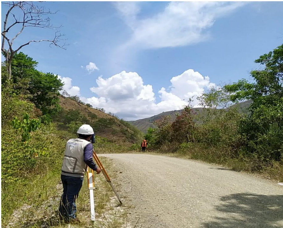
Figura 3: Trabajo levantamiento topográfico
