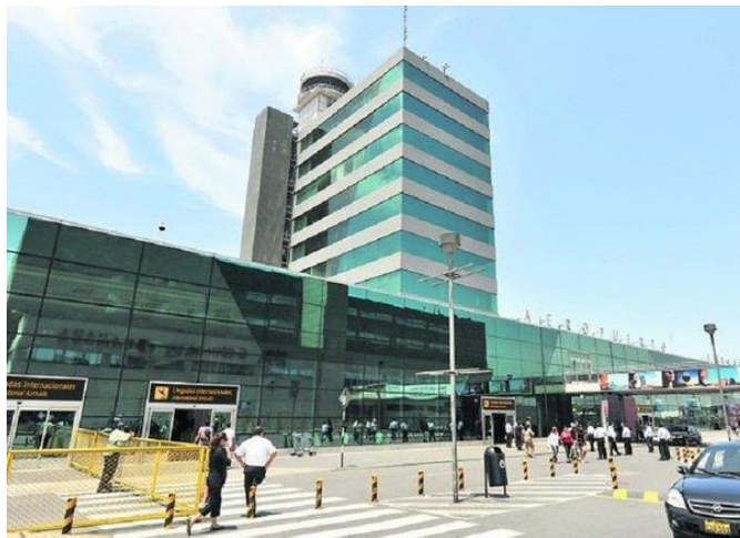
Figura 1. Vista Panorámica del Aeropuerto Jorge Chávez
