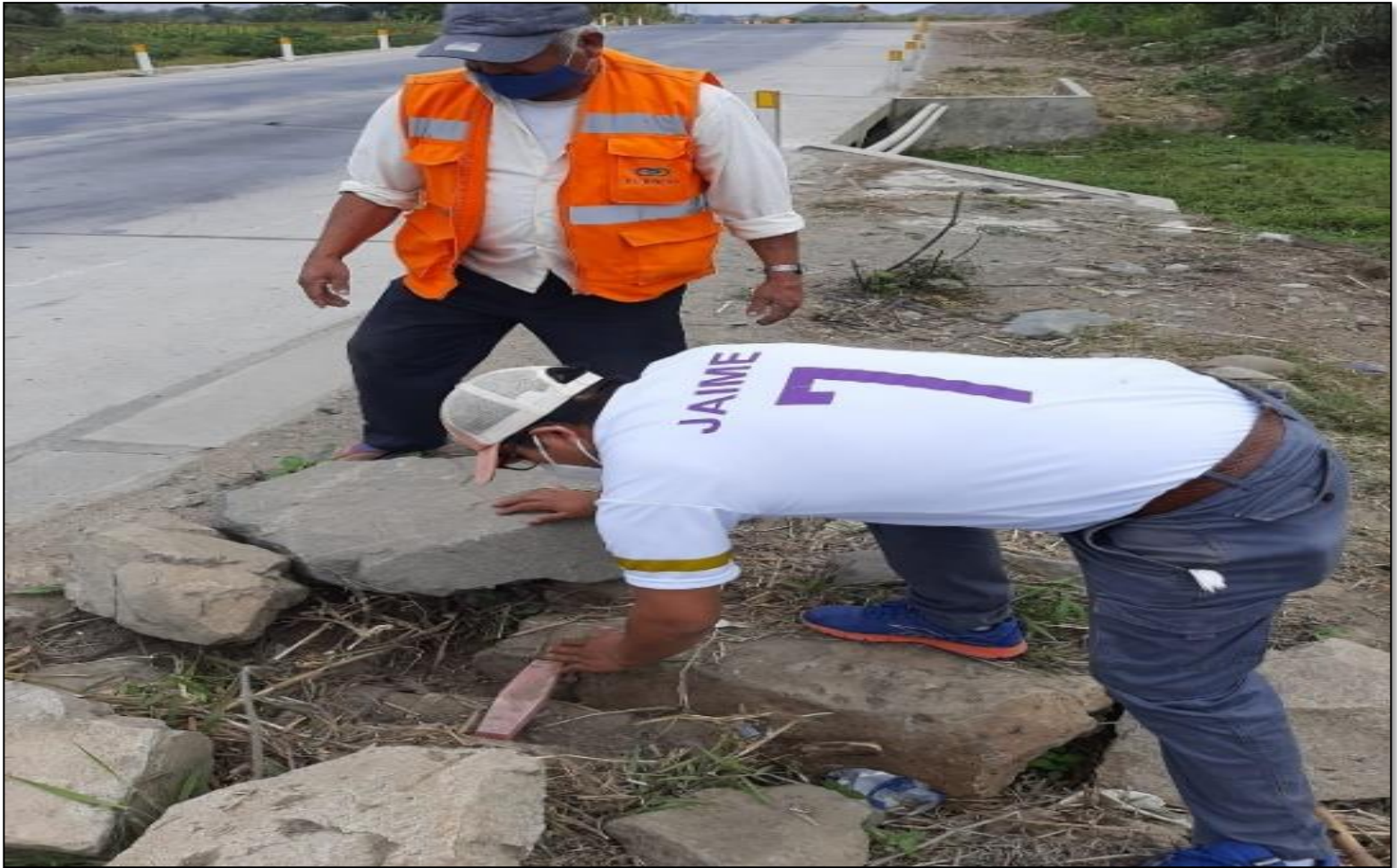
Válvula de purga en tubería de abastecimiento existente en la línea de conducción.
