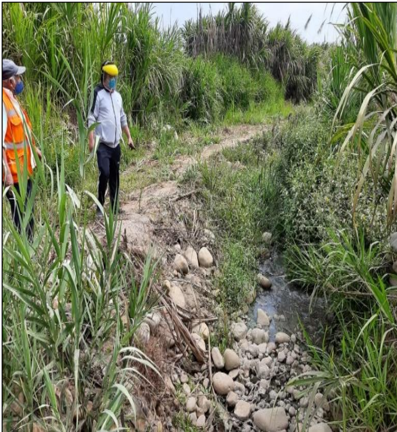
Zona de descarga de aguas residuales.
