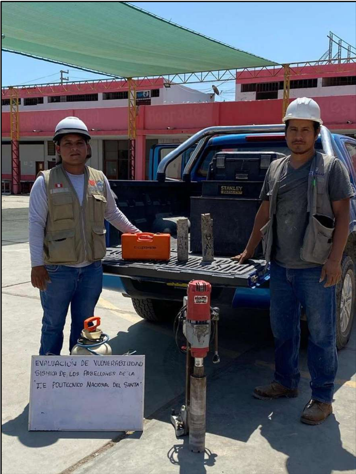
FOTOGRAFIA N° 21. DIAMANTINAS PARA SU ENSAYO EN LABORATORIO
