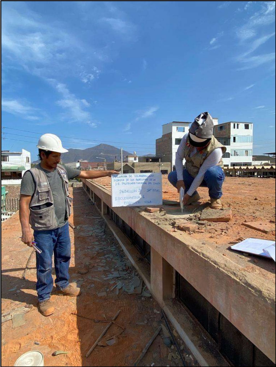
FOTOGRAFIA N° 15. ENSAYO DE ESCLEROMETRIA N° 6
