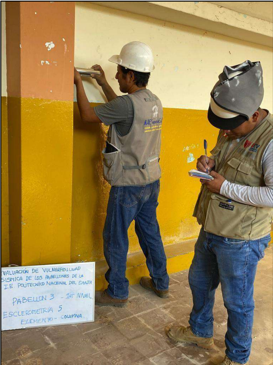
FOTOGRAFIA N° 14. ENSAYO DE ESCLEROMETRIA N° 5
