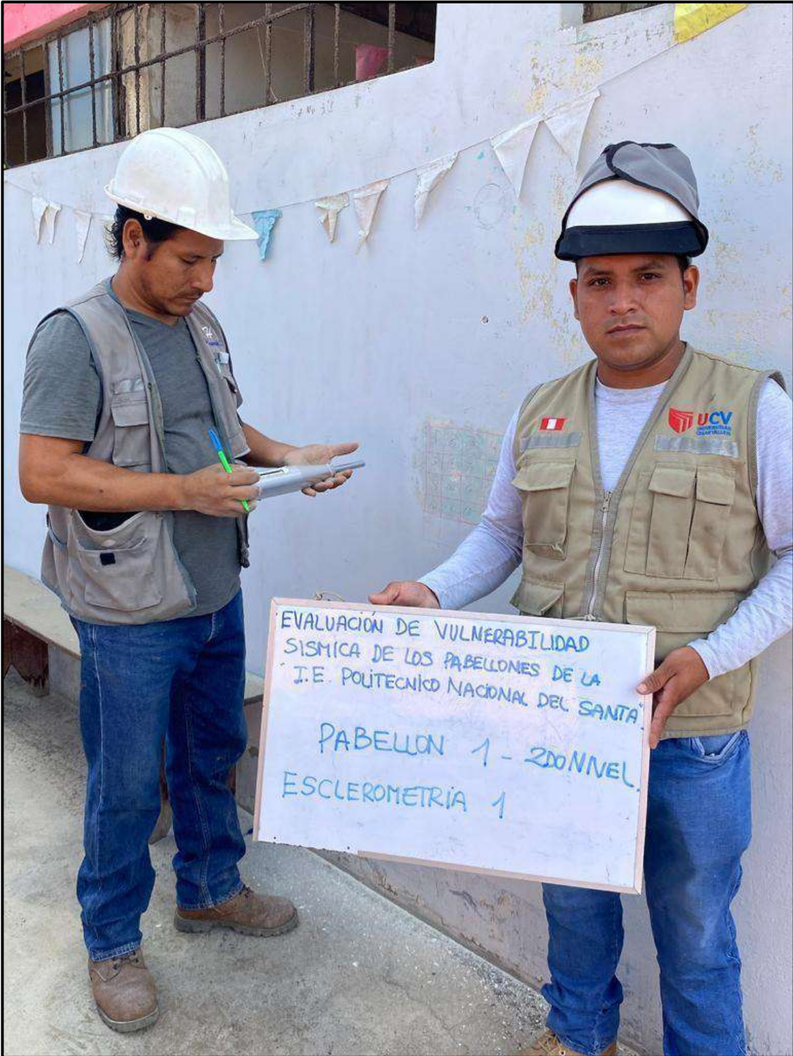
FOTOGRAFIA N° 10. ENSAYO DE ESCLEROMETRIA N° 1
