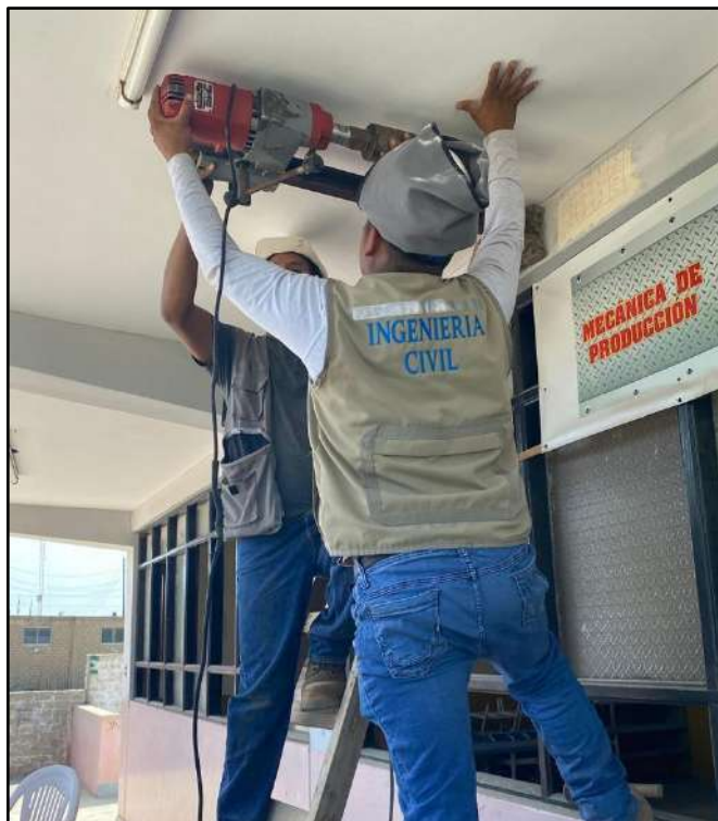
FIGURA N° 4 EXTRACCION DE DIAMANTINA
