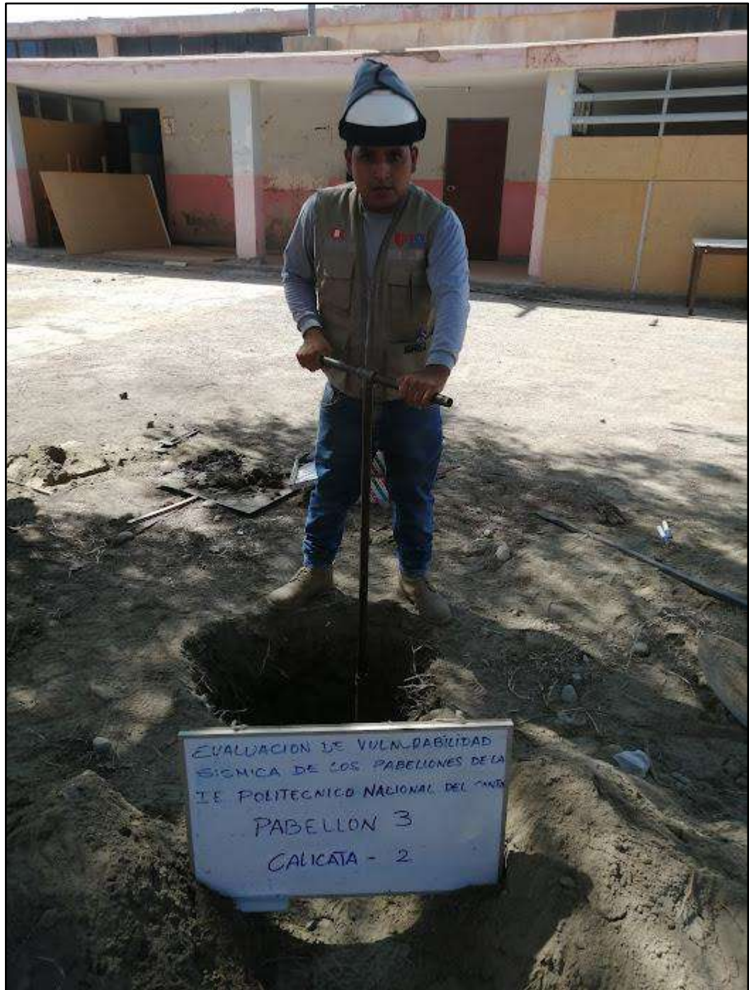
FIGURA N° 5 EXTRACCION DE MATERIAL
