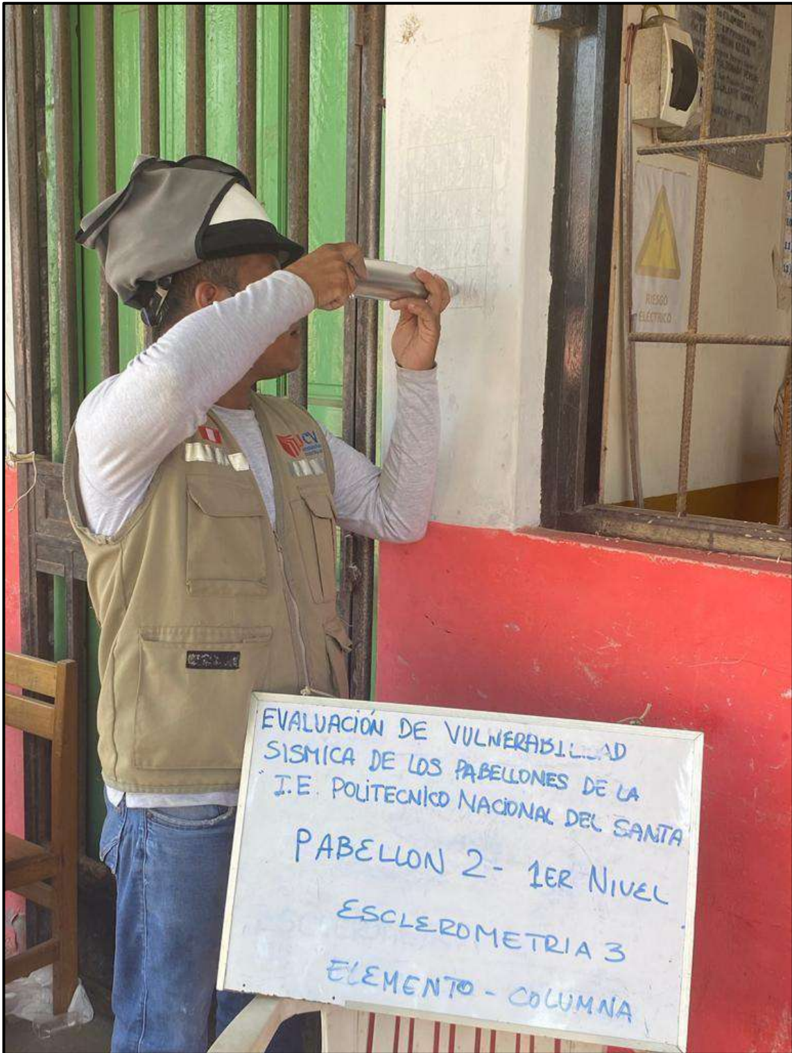
FOTOGRAFIA N° 12. ENSAYO DE ESCLEROMETRIA N° 3
