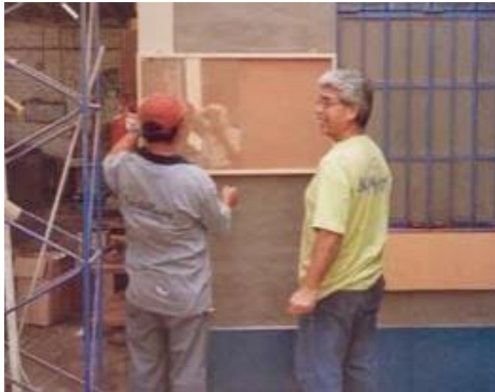
Figura 35. Instalación de banner instructivo y periódico mural 5S
