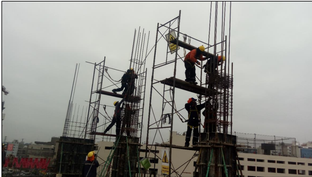
Figura 40. Colocación de acero dimensionado , después de encofradas las columnas y las placas. Propia, 2017.
