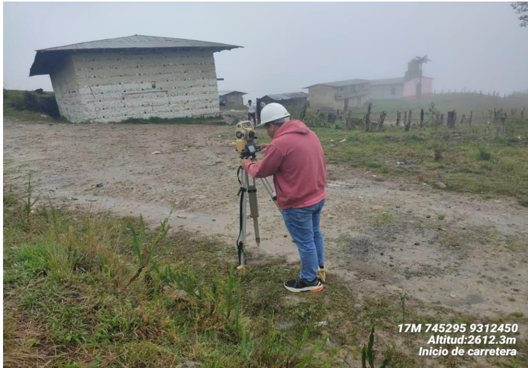
Figura 5. Inicio del Tramo – Chorro Blanco.
