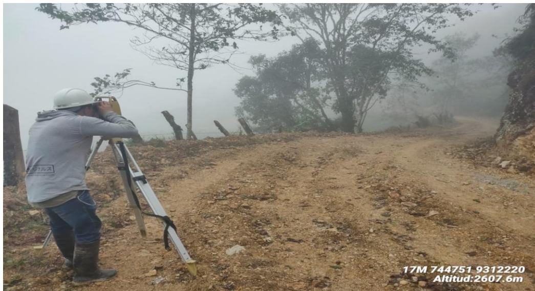
Figura 6. Levantamiento de la vía existente.
