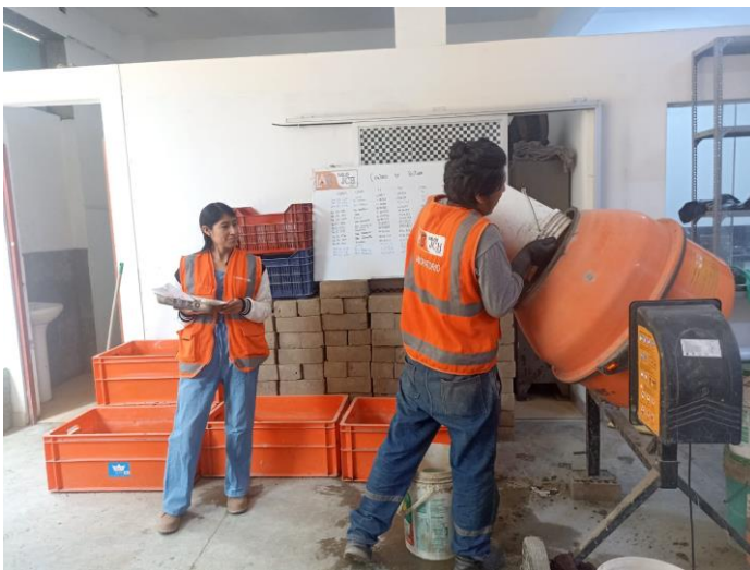
Verificando la dosificación de mezcla del concreto
