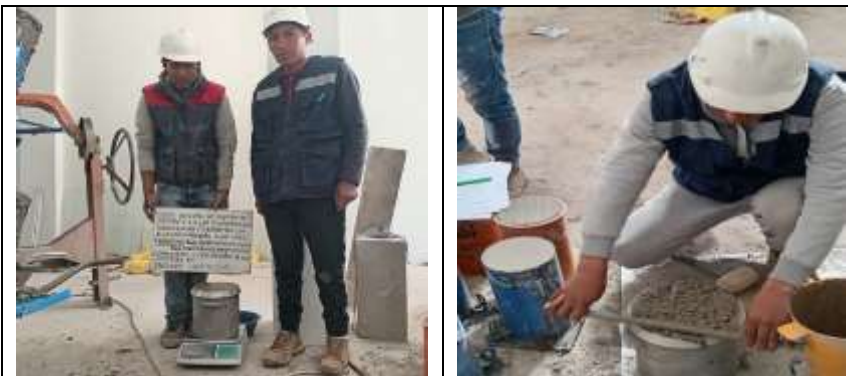
Ensayo de densidad del concreto
