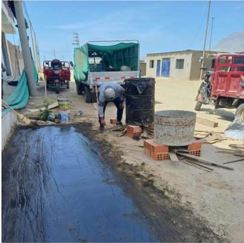
**Anexo 19.24.** Proceso de mezcla homogénea en caliente de agregados para diseño MAC.
