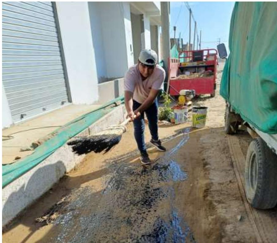
**Anexo 19.23.** Plataforma de carpeta asfáltica completa con imprimante MC 30.
