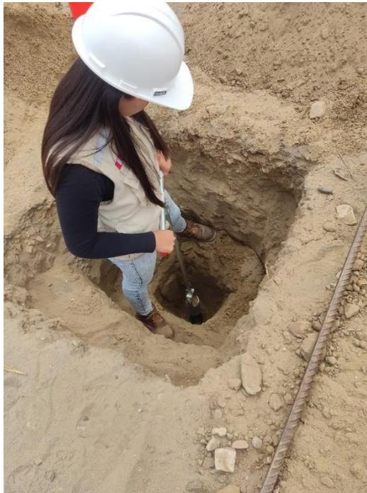
IMAGEN 04: REALIZAMOS LA EXCAVACION DE LAS CALICATAS A 1.5 METROS DE PROFUNDIDAD
