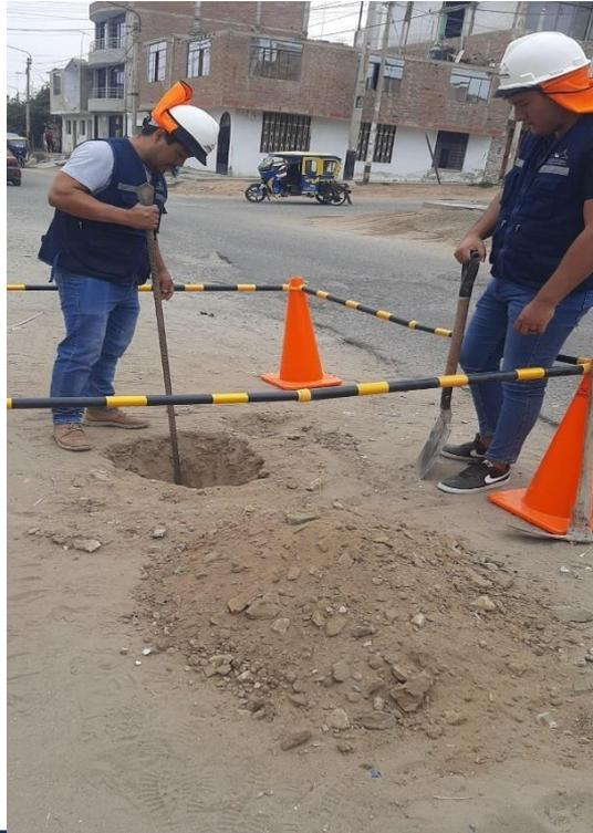
IMAGEN 03: INICIAMOS MARCANDO LA SECCION PARA LA PRIMERA CALICATA A REALIZAR, CON EL APOYO DEL LABORATORIO CRISAL, DONDE ESTAMOS DESARROLLANDO NUESTROS ENSAYOS
