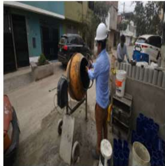
FOTO N°8: DESCRIPCION: Adición de Fibra de Acero
