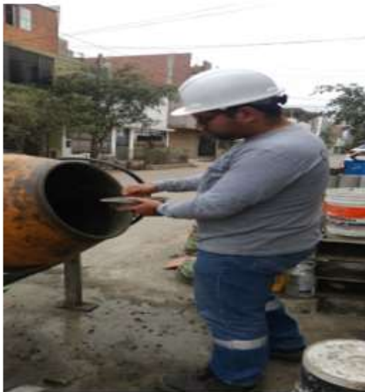
FOTO N°7: DESCRIPCION: Adición de Desecho Cerámico
