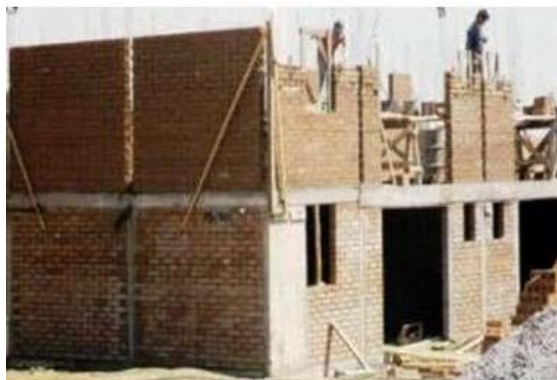
Figura 8. Viviendas de albañilería confinada
