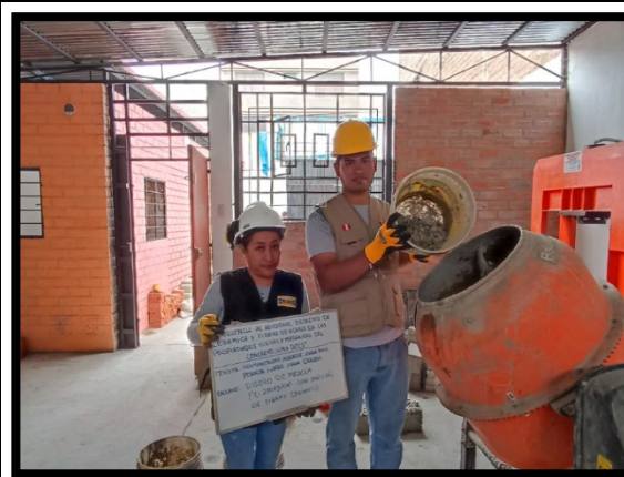
FOTOGRAFIA 34: Introduciendo el agregado grueso a la mezcladora
