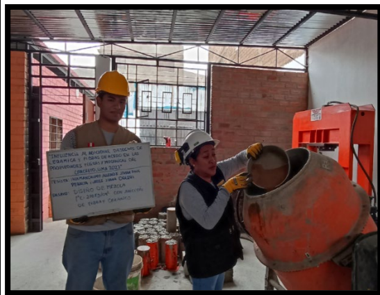
FOTOGRAFIA 37: Introduciendo el desecho de cerámica a la mezcladora
