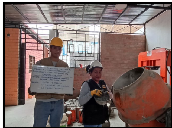
FOTOGRAFIA 38: Introduciendo las fibras de acero a la mezcladora
