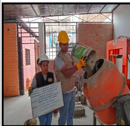
FOTOGRAFIA 35: Introduciendo el agregado fino a la mezcladora
