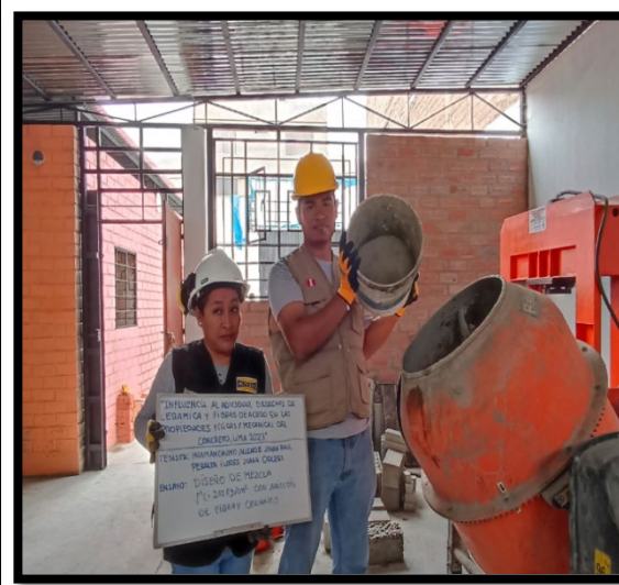
FOTOGRAFIA 36: Introduciendo el cemento portland a la mezcladora
