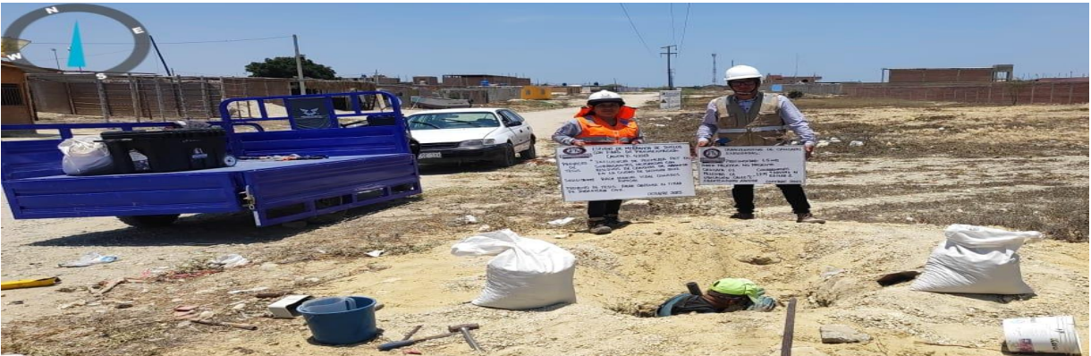
Exploración de calicatas
