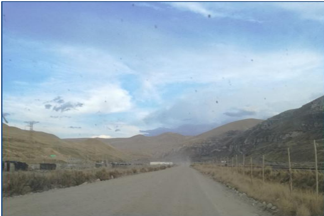
Figura 3. 1. Vista panorámica de inicio de la carretera JU-1029
