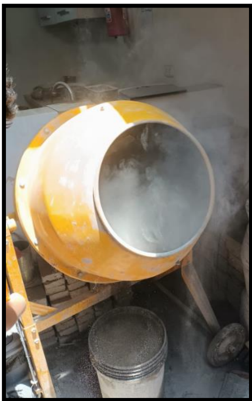
Fotografía 12. Proceso de mezclado del concreto en trompo
