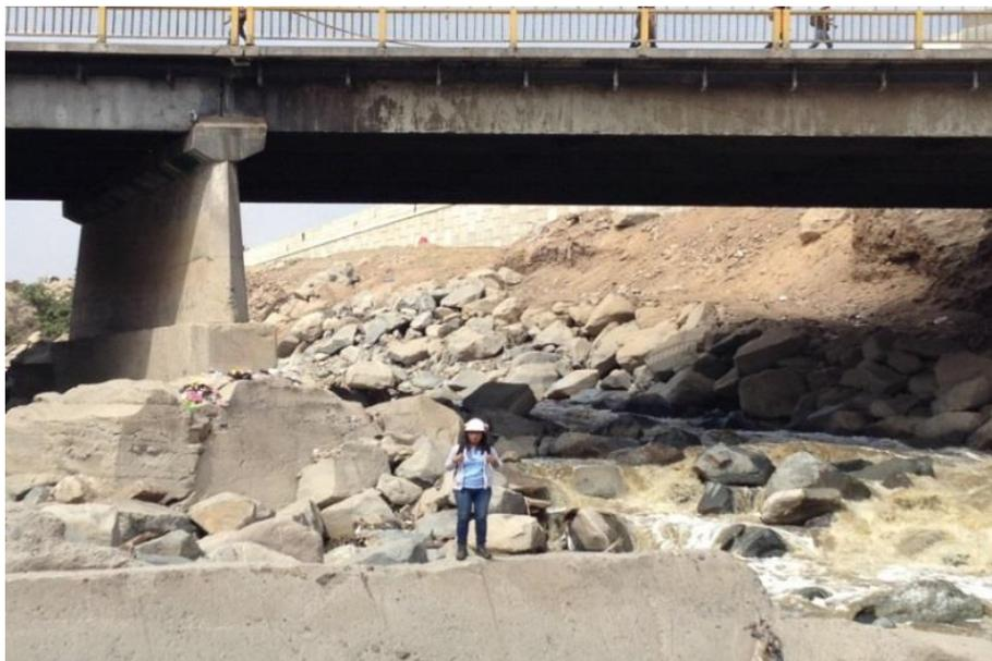
Figura I-2: Socavación en el pilar intermedio
