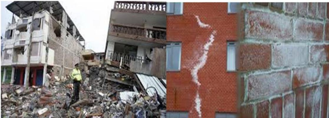
**Figura1.1.** Daños de edificaciones después de un sismo-Eflorescencia en unidades de albañilería
