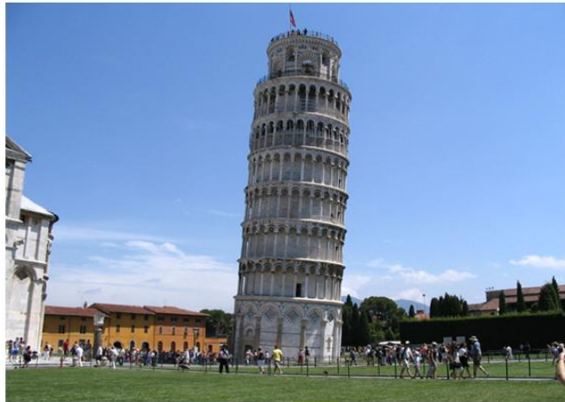
Figura N°1 La Torre de Pisa: Una deficiente cimentación provocó que, con el paso del tiempo, el campanario de la Catedral de la ciudad de Pisa comenzara a inclinarse sensiblemente.
