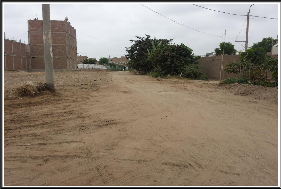
Foto N° 09: Estado actual de la Vía 01.
