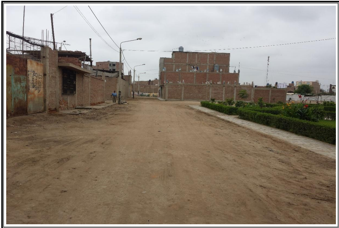
Foto N° 08: Estado actual de la Calle Solf y Muro.
