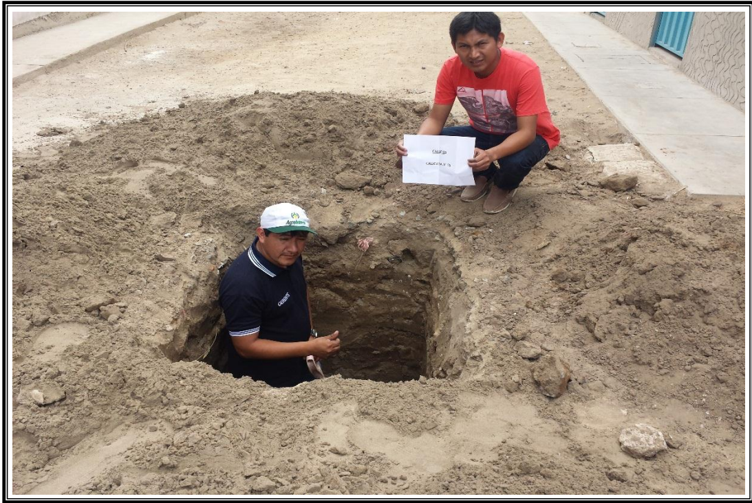
Foto N° 13: extracción de muestras de suelo de calicata en la zona en estudio.
