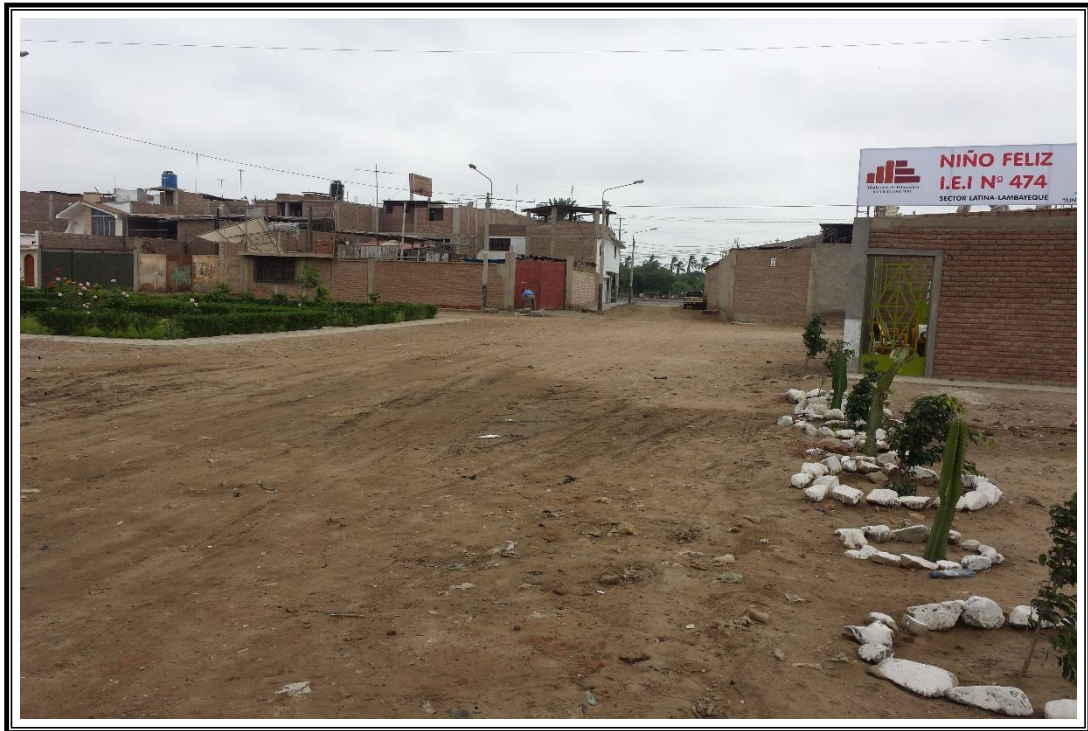
Foto N° 04: Estado actual de la Calle 02.
