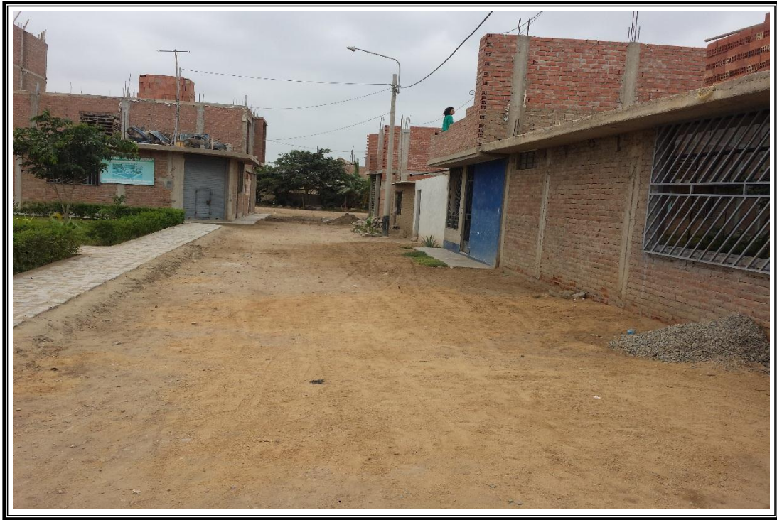
Foto N° 05: Estado actual de la Calle 03.
