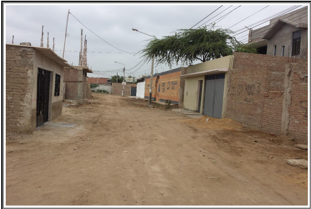
Foto N° 06: Estado actual de la Calle 04.
