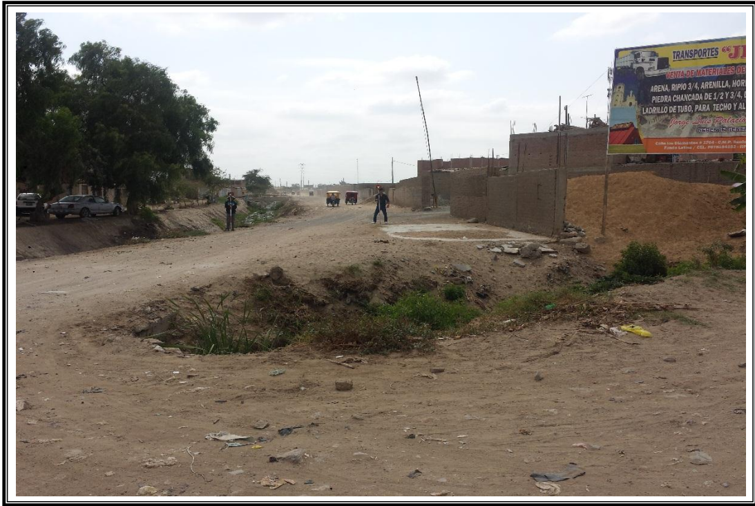
Foto N° 03: Estado actual de la Calle 01.
