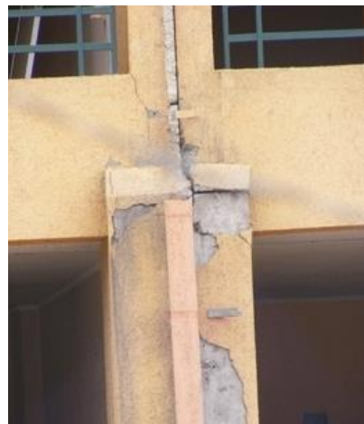
Figura 1.19. Edificación sin junta de separación.
