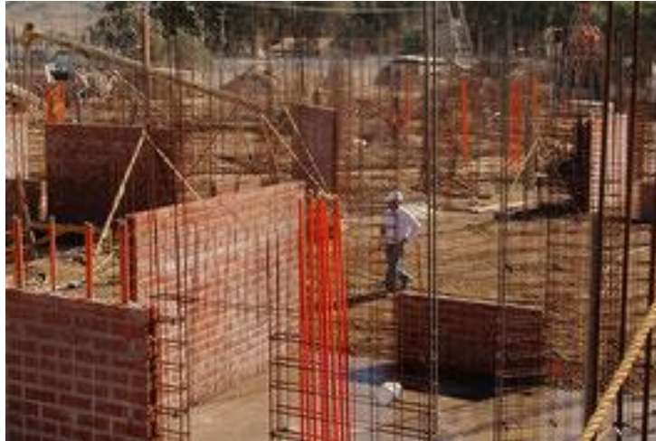
Figura 1.1. Vivienda Construida con Albañilería Armada
