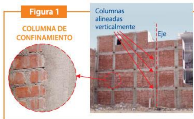
Figura 1.2. Vivienda Construida con Albañilería Confinada
