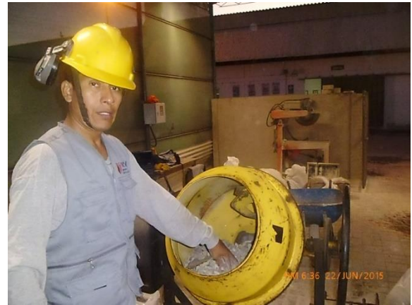
Figura 4.49. Ingreso de los materiales en la máquina mezcladora.
