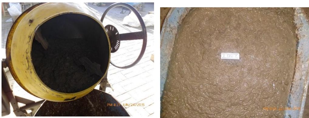
Figura 4.53. Muestreo del concreto fresco y medición de la temperatura.
