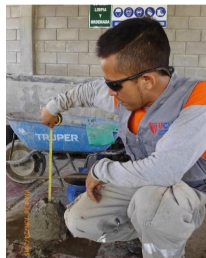
Figura 4.59. Medición del asentamiento en
