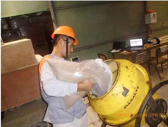
Figura 4.50. Vista del ingreso de los materiales antes de ser mezclados.
