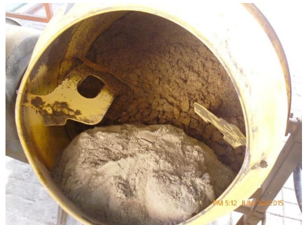
Figura 4.51. Vista de los agregados mezclados y el material cementante.
