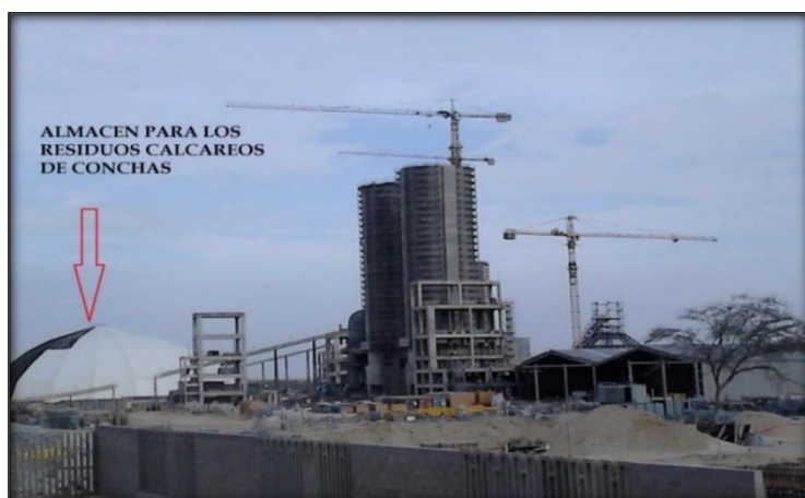
Figura 3.1. Vista de la nueva planta cementera de Piura, a un 90% de su construcción. A la izquierda se indica el gran almacén para los
