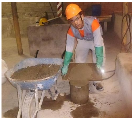
Figura 4.61. Vista del enrasado de la superficie de la última capa de concreto fresco.
