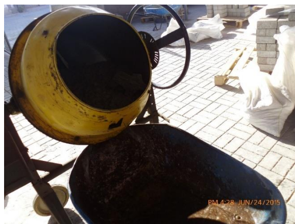
Figura 4.52. Muestreo del concreto fresco.
