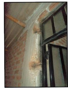
ILUSTRACIÓN N° 14: Refuerzo de acero debilitado por intemperie
