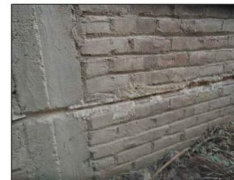
ILUSTRACIÓN N° 11: Debilitamiento de columna y muro
