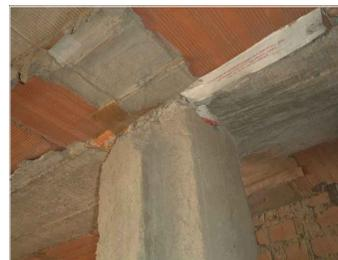
ILUSTRACIÓN N° 29 Mal confinamiento en el encuentro columna - viga
