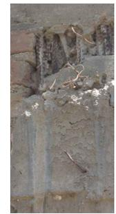
ILUSTRACIÓN N° 36: Presencia de cangrejeras en columna
