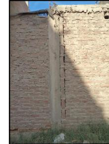
ILUSTRACIÓN N° 01: Falta de confinamiento muro-columna
