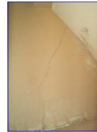
ILUSTRACIÓN N° 21: Presencia de fisura en muro
