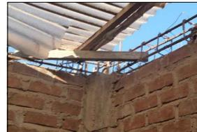
ILUSTRACIÓN N° 27. Acero expuesto a la intemperie
