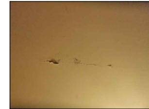
ILUSTRACIÓN N° 22: Presencia de hueco en cielo raso
