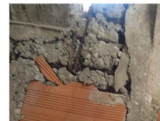
ILUSTRACIÓN N° 30 Presencia de cangrejas en viga
