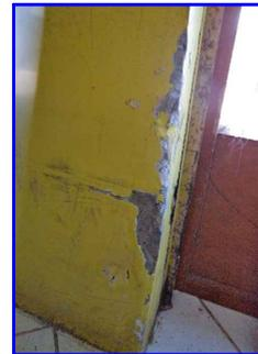
ILUSTRACIÓN N° 19: Desmoronamiento del concreto de columna
