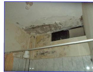
ILUSTRACIÓN N° 23: Presencia de humedad en baño y paredes
