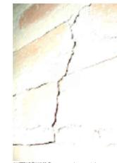
ILUSTRACION N° 02: Fisura en muro de mampostería
