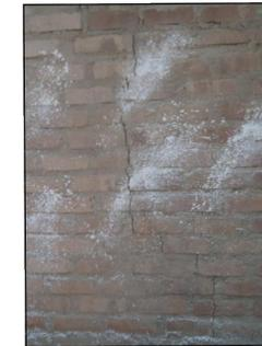
Presencia de grietas en los muros de mampostería, debido al asentamiento del suelo.
