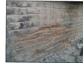
ILUSTRACIÓN N° 10: Unidades de mampostería deterioradas
