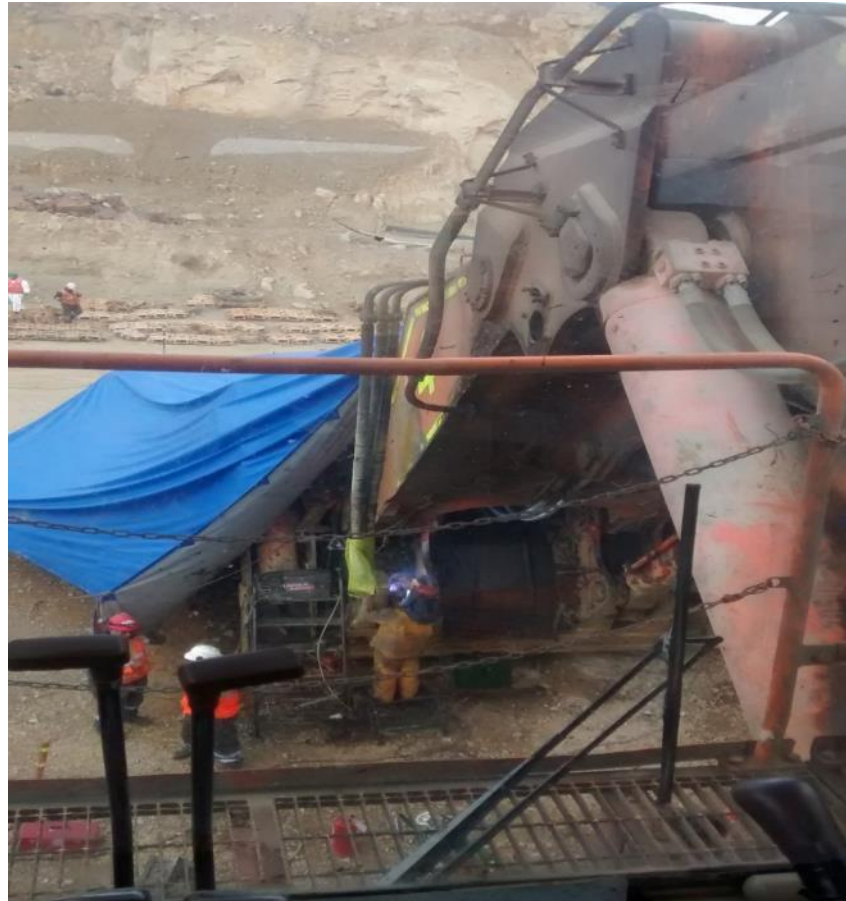
Realizando trabajos de soldadura en cucharón de pala en campo
