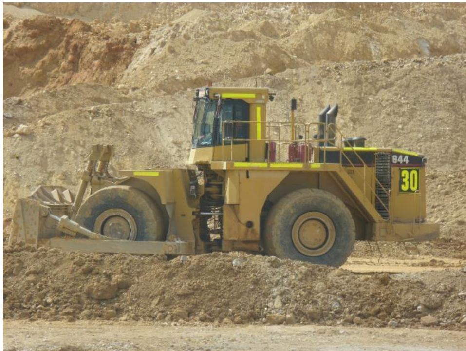
Tractor de ruedas - RT en campo realizando una berma.
