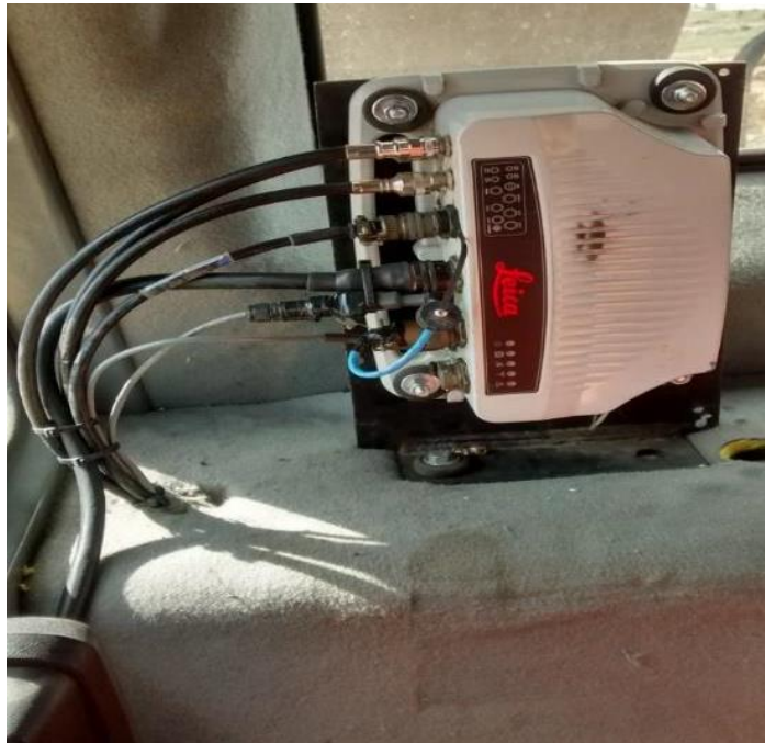
Instalación de Hub UHP del sistema de control de flotas Leica Geosystems de baja precisión en el interior de la cabina de un camión 793C.
